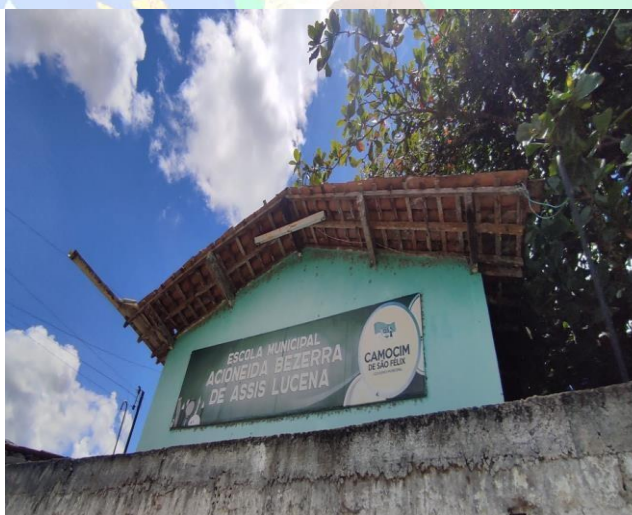
Revisão geral de cobertura e elétrica
