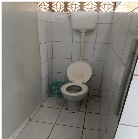
MANUTENÇÃO TOTAL DOS BANHEIROS E RALOS
