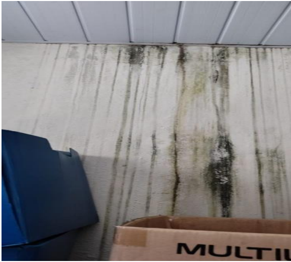
Infiltração decorrente de cobertura
