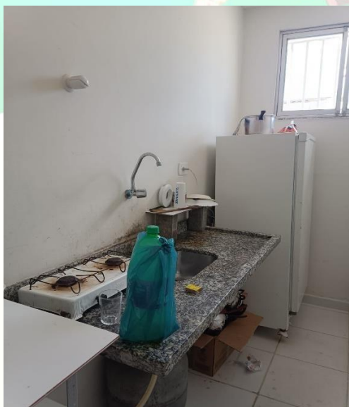
REVESTIMENTO DAS PAREDES
