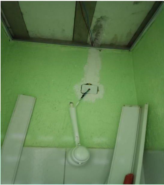
MANUTENÇÃO EM TOTOS OS BANHEIROS
