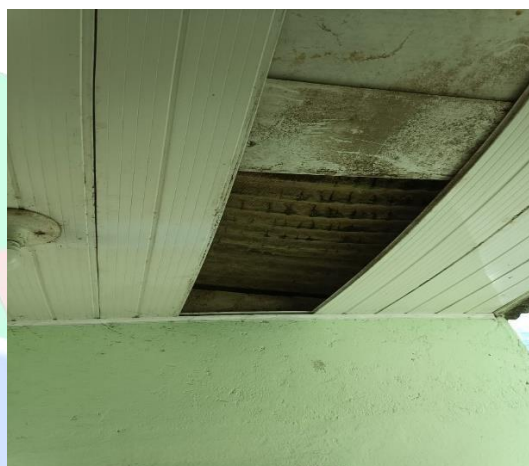
MANUTENÇÃO TOTAL DO TELHADO
