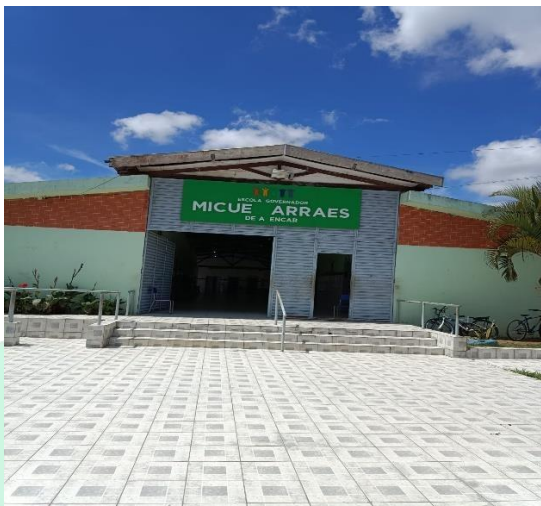
PINTURA EXTERNA DE PAREDES E PORTÕES
