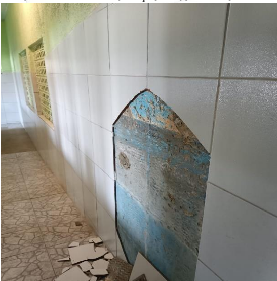
REVESTIMENTO DO PISO E PAREDE
