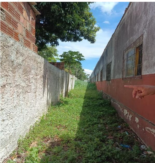
PINTURA EXTERNA TOTAL
