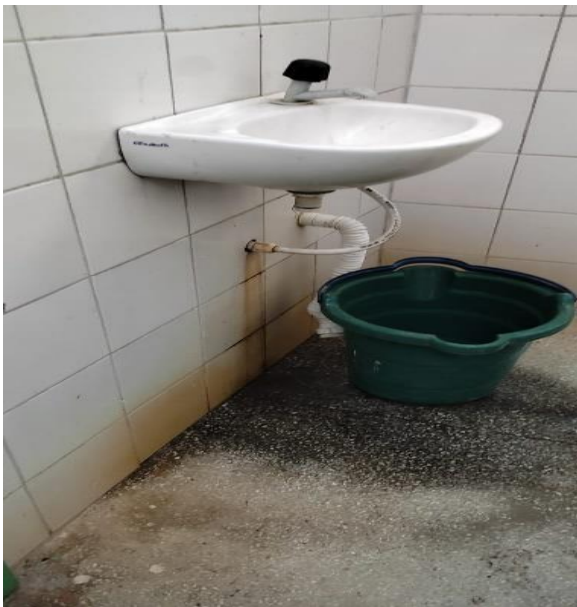
Conexões hidráulica danificadas
