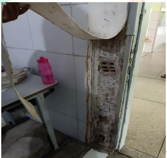
REVESTIMENTO DAS PAREDES
