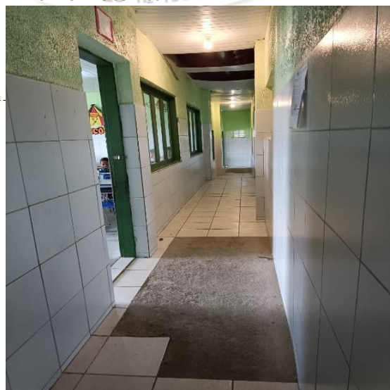
MANUTENÇÃO GERAL DO FORRO EM PVC
