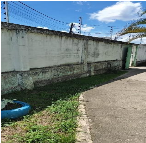
Pintura interna de muro da fachada
