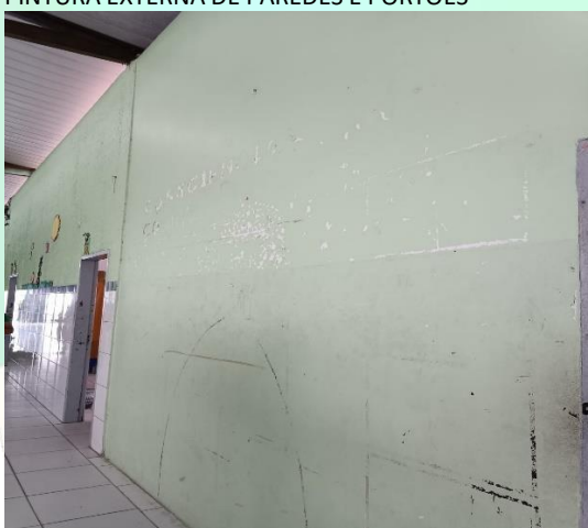
PINTURA INTERNA TOTAL
