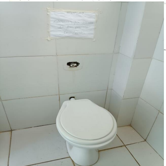
MANUTENÇÃO NAS DESCARGAS
