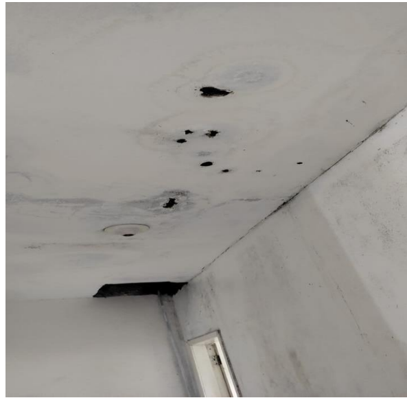
Substituição de Forro de gesso (infiltrações)
