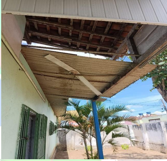
MANUTENÇÃO NA COBERTA DA PASSAGEM DA RECREAÇÃO
