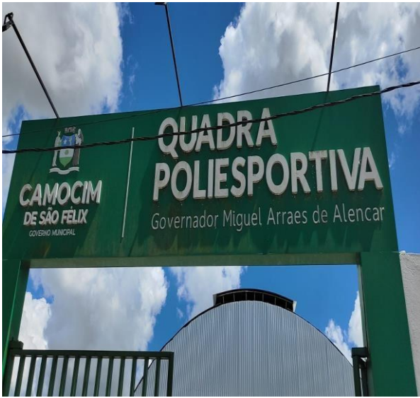
Limpeza de ACM
