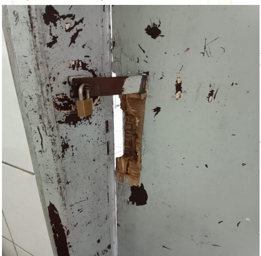
PORTAS E FECHADURAS OBS: REVISÃO GERAL DA ELÉTRICA
