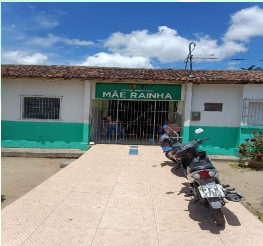
PINTURA EXTERNA E MANUTENÇÃO DA COBERTA TOTAL
