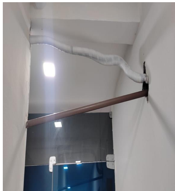
Tubulação e dutos expostos
