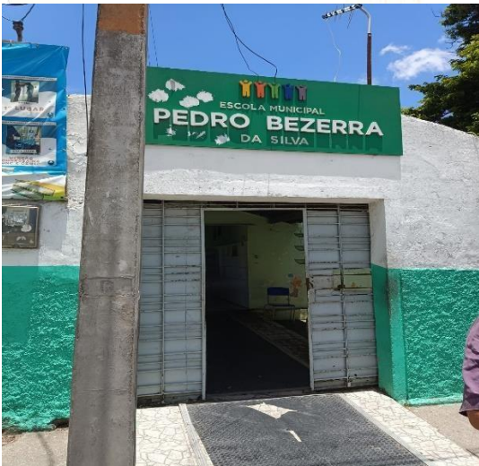
FACHADA FRONTAL/PINTURA GERAL
