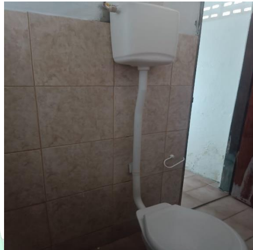
MANUTENÇÃO NA CAIXA DE DESCARGA
