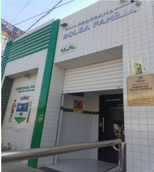
MANUTENÇÃO NO ACM DA FACHADA
