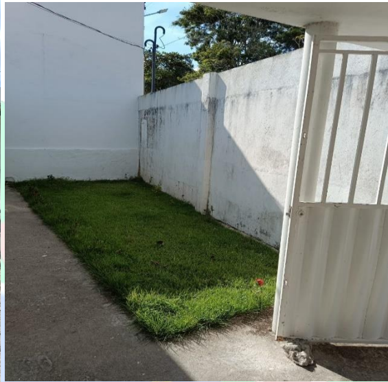
FACHADA FRONTAL FACHADA
