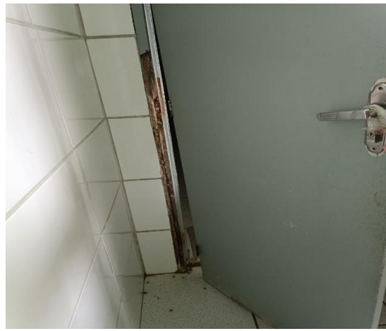
MANUTENÇÃO EM PORTAS E FECHADURAS
