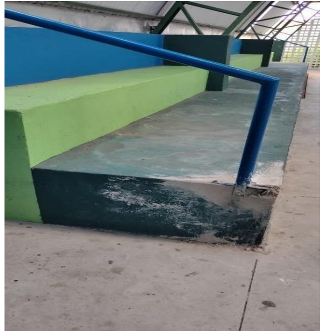
Pintura de arquibancada
