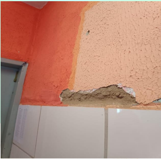
REBOCO E PINTURA INTERNA OBS: REVISÃO DA ELÉTRICA GERAL
