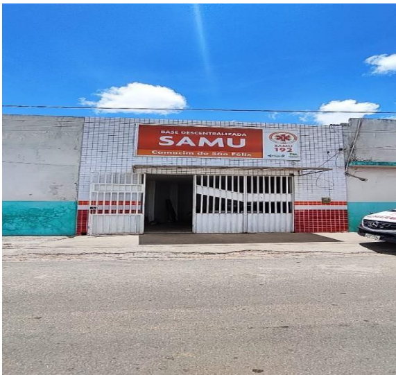
Restauração de Fachada
