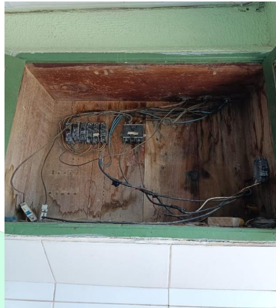
REVISÃO TOTAL DA ELÉTRICA
