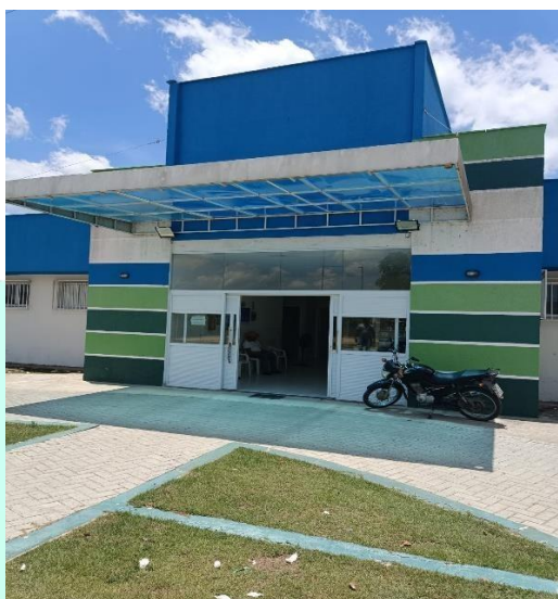
FACHADA FRONTAL/ FALTA PLACA
