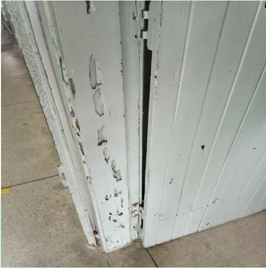
PORTAS COM CUMPIM OBS: REVISÃO DA ELÉTRICA GERAL
