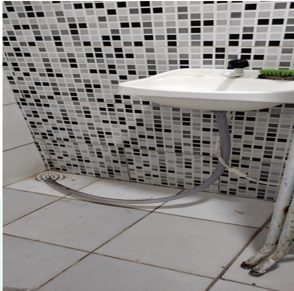
Conexões hidráulica improvisadas
