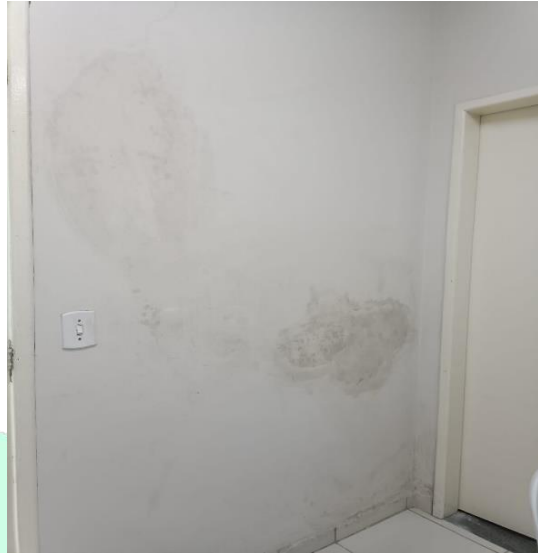
PINTURA INTERNA TOTAL
