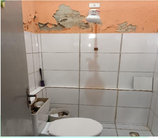
MANUTENÇÃO EM TODOS OS BANHEIROS
